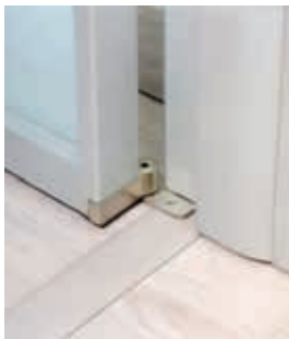
cerniera inferiore standard
